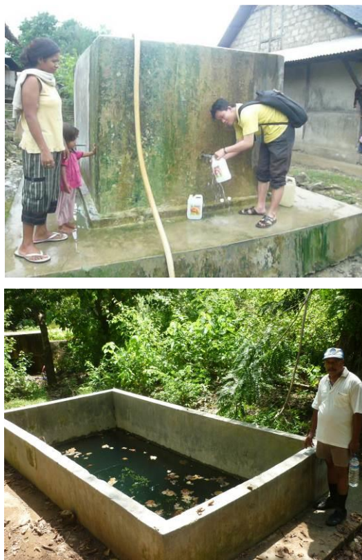
Gambar 2.56 Bak Penampungan Air Hujan di WS Kepulauan Yamdena-Wetar
