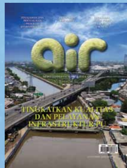
Banjir Kanal Barat
