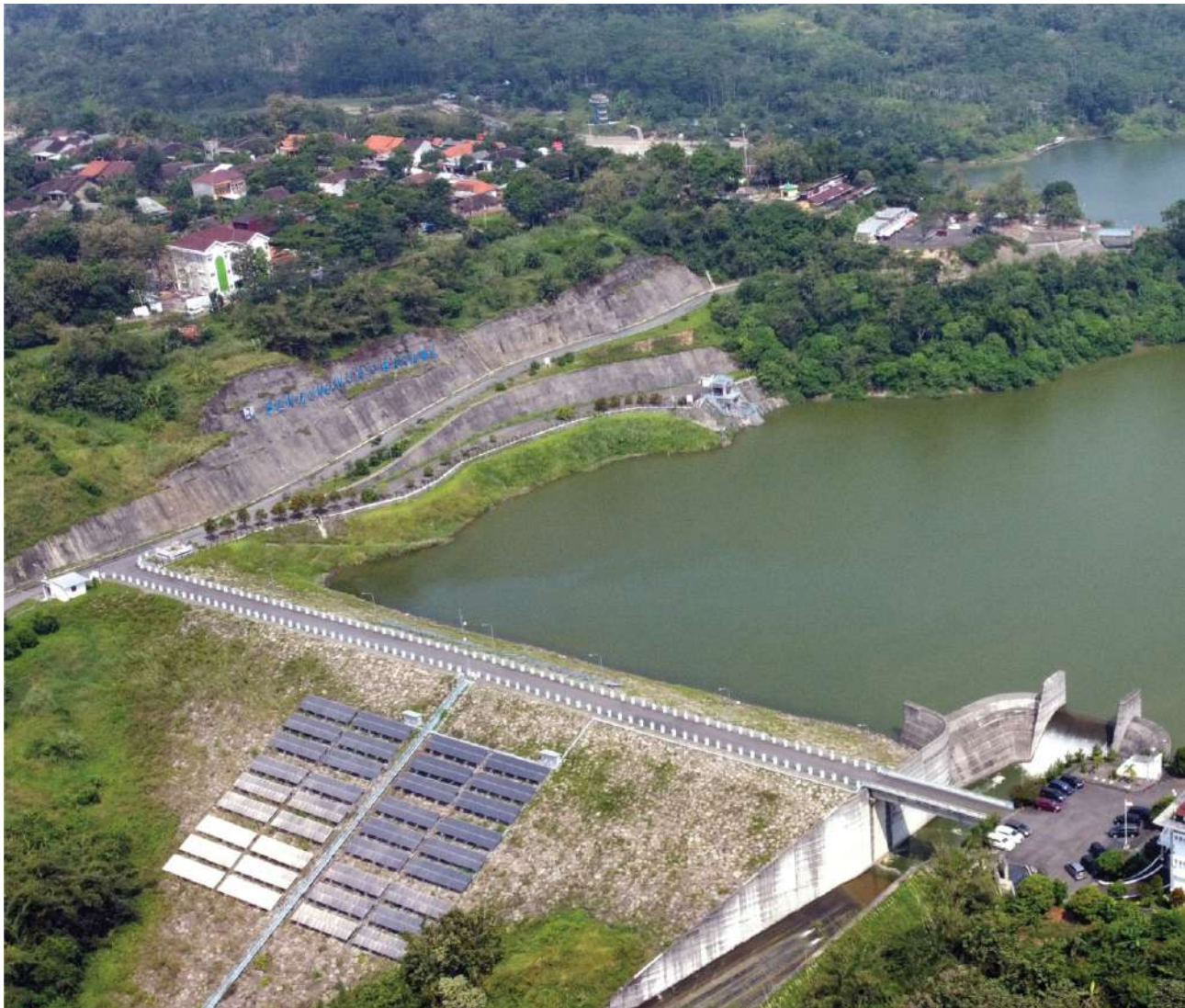
Bendungan Jatibarang (PLTS)
