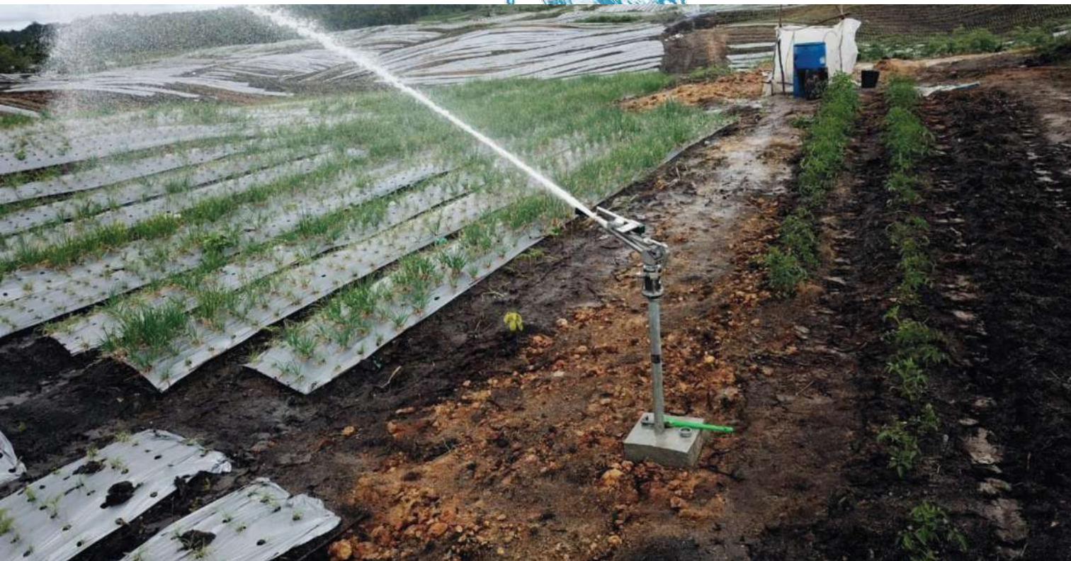
Kementerian PUPR melanjutkan pembangunan sejumlah infrastruktur di Food Estate Humbang Hasundutan dalam rangka mewujudkan Ketahanan Pangan
