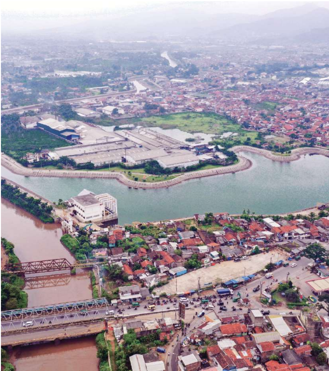
Kolam Retensi Cieunteung
