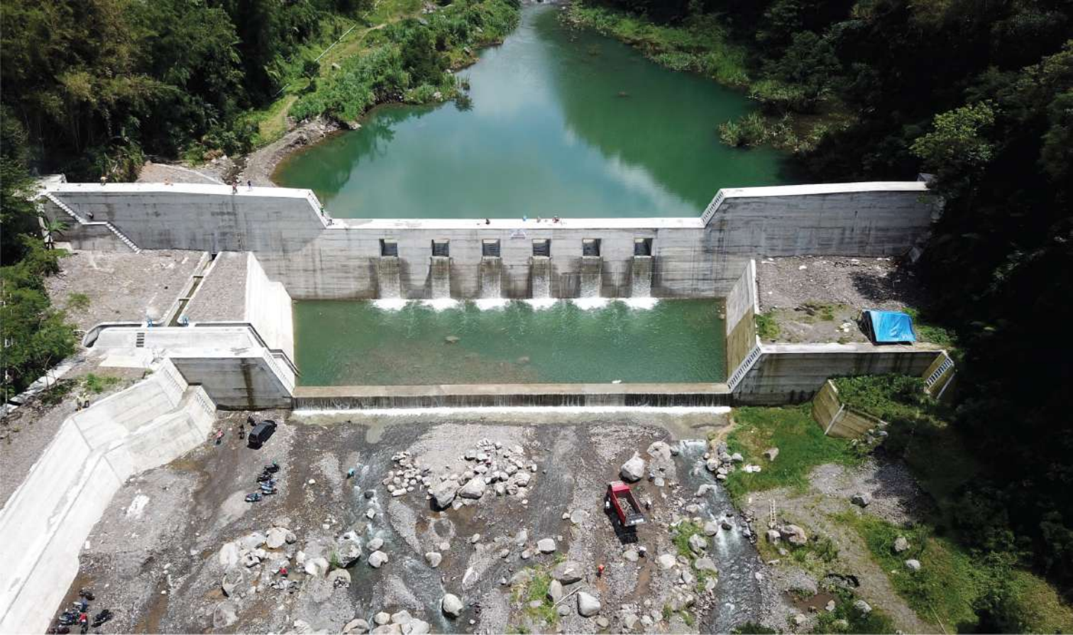
Sabo Dam Kali Pabelan di Desa Kapuhan (D.I. Yogyakarta) untuk Mengantisipasi Banjir Lahar dari Gunung Merapi
