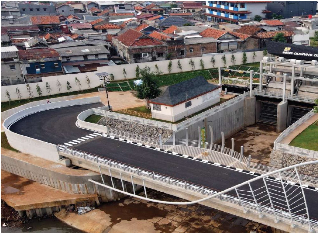
Pembangunan Sodetan dari Sungai Ciliwung menuju Kanal Banjir Timur
