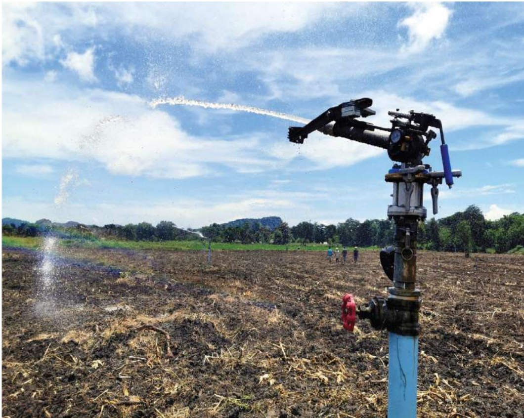
Pembangunan Jaringan Irigasi Sprinkler (Big Gun) yang Bersumber dari Bendungan (Program Food Estate di Kabupaten Belu)
