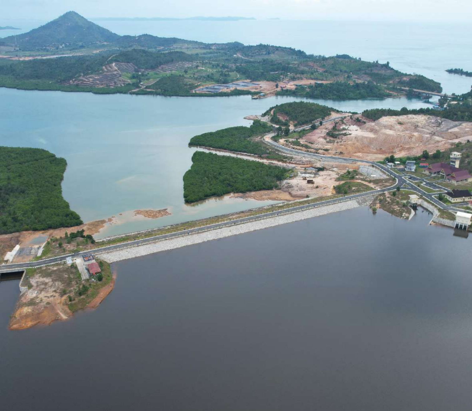
Bendungan Sei Gong di Kepulauan Riau
