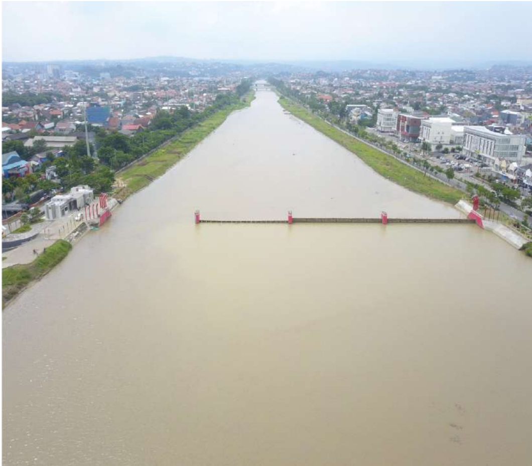
Bendung Gerak Kanal Banjir Barat di Semarang
