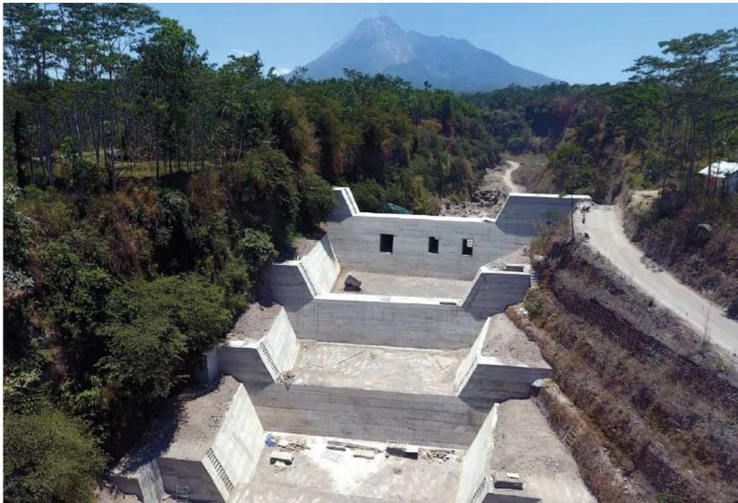
Membangun 7 Sabo Dam Baru untuk Mengurangi Risiko Bencana Banjir Lahar Gunung Merapi
