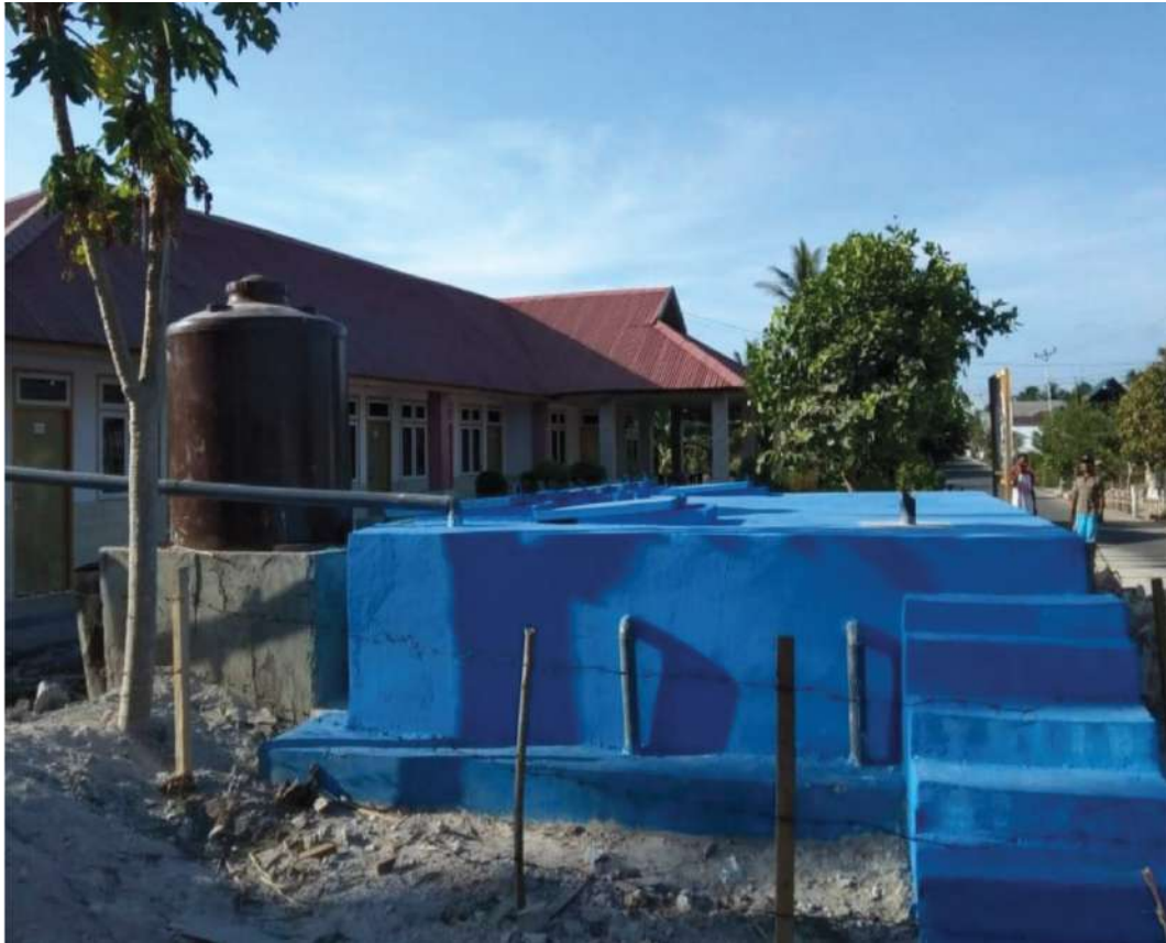
Pembangunan Akuifer Buatan Simpanan Air (ABSAH)
