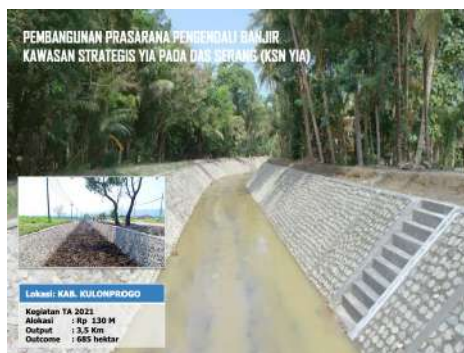
Gambar 18. Pembangunan Prasarana Pengendali Banjir KSN YIA
