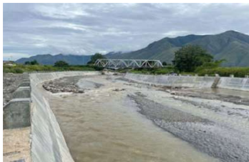
Gambar 38. Pengendalian Daya Rusak Sungai Binanga Siguluan Kab. Samosir
