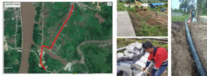
Gambar 30. Pembangunan Pipa Transmisi Kota Tanjung Selor
