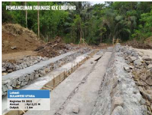
Gambar 23. Pembangunan Drainase KSPN Likupang
