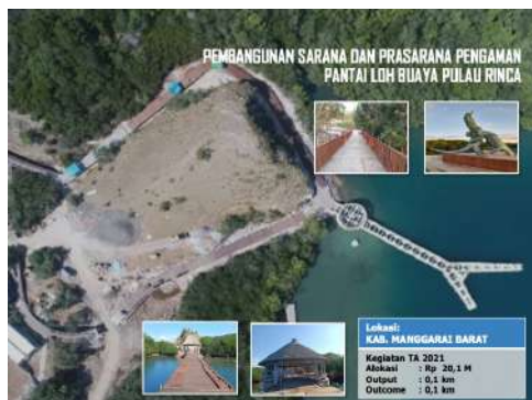
Gambar 21. Pembangunan Pengaman Pantai Loh Buaya
