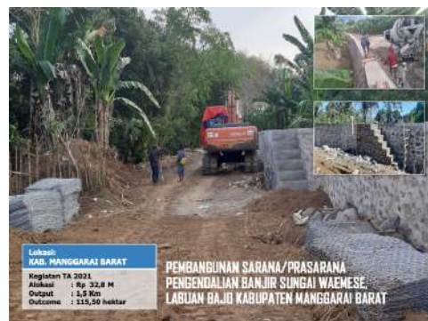
Gambar 22. Pembangunan Pengendali Banjir KSPN Labuan Bajo
