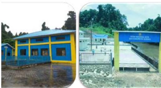
Gambar 29. Rehabilitasi Intake SPAM Kota Sorong
