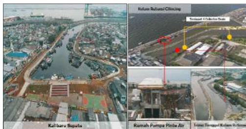
Gambar 39. Lokasi Pembangunan Pengaman Pantai Jakarta
