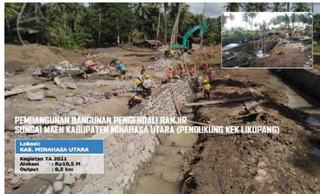
Gambar 24. Pembangunan Pengendali Banjir Pendukung KSPN Likupang
