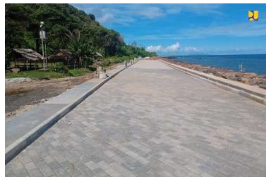
Gambar 32. Pengaman Pantai KEK Tanjung Lesung Kab. Pandeglang
