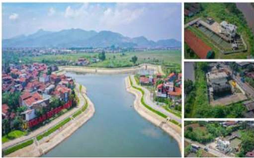
Gambar 36. Pembangunan Kolam Retensi Andir dan Polder-Polder
