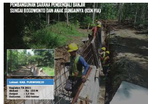
Gambar 19. Pembangunan Sarana Pengendali Banjir Sungai Bogowonto
