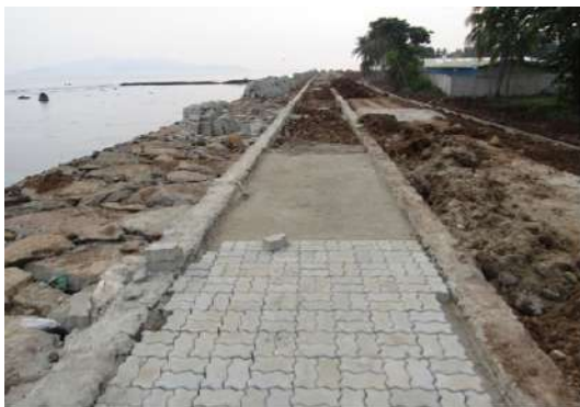
Gambar 31. Pengaman Pantai Kalianda Kab. Lampung Selatan
