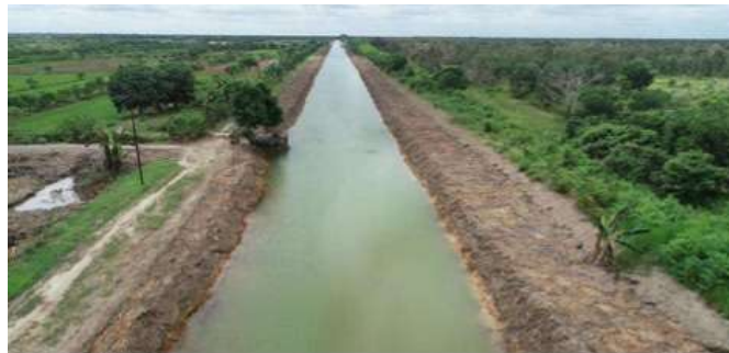
Gambar 11. Saluran Kolektor pada DIR Wilayah Kerja Blok A
