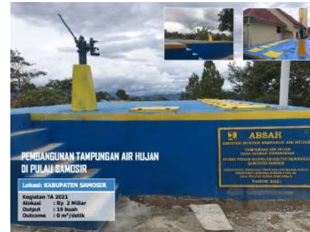
Gambar 17. Pembangunan Tampungan Air Hujan Pulau Samosir
