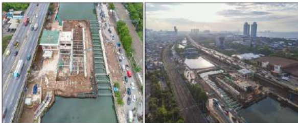
Gambar 41. Pembangunan Pompa Ancol Sentiong
