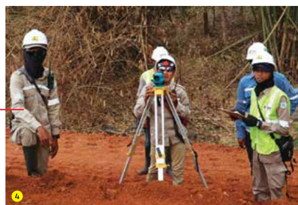
Gambar 2. Pengecekan Gambar Rencana Kerja. Gambar 3. Uji Kepadatan Timbunan Tanah. Gambar 4. Pengukuran Elevasi Tanggul.
