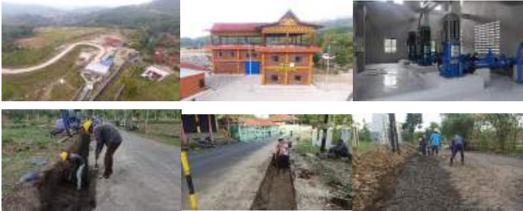
Pembangunan Sarana dan Prasarana Penyediaan Air Baku Bendungan Kuningan Kabupaten Kuningan
