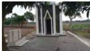
Perbaikan Masjid di Bendungan Rancabeureum Kab. Indramayu
