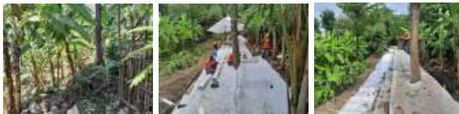
Perkuatan Tebing Sungai Cimanuk Desa Sukagumiwang Kec. Sukagumiwang Kab. Indramayu (100%)
