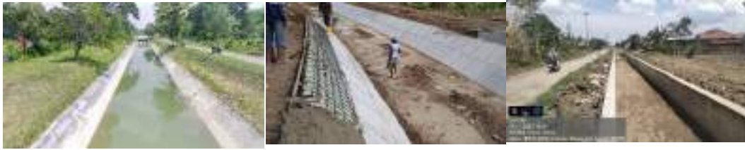
Rehabilitasi Jaringan Irigasi DI. Jengkelok Kabupaten Brebes
