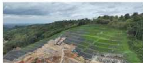
Progres Pembangunan Proteksi Lereng
