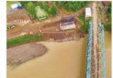
Pekerjaan Jembatan Hilir Permanen
