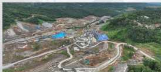
Progres Pembangunan Hulu Bangunan Pelimpah
