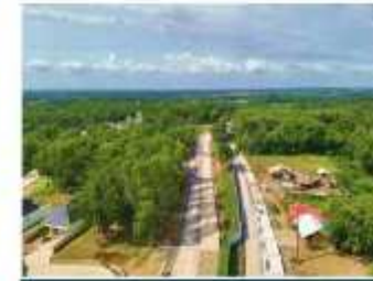
Pekerjaan Lantai Kerja Jalan Relokasi Eksisting Hilir
