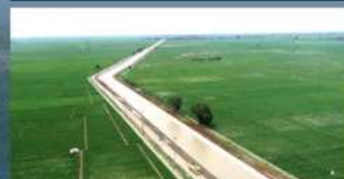
Rehabilitasi, Peningkatan, dan Modernisasi Jaringan Irigasi SS. Anjatan
