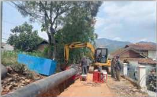
Pemasangan Pipa Transmisi
