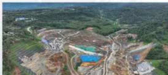
Progres Pembangunan Hilir Bangunan Pelimpah
