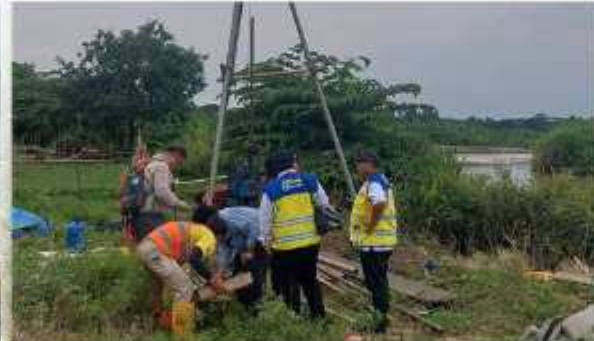
Monitoring pelaksanaan pengeboran/ Survei Geoteknik pada titik DH .07
