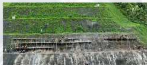
Progres Pembangunan Soilnailing
