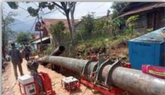
Pemasangan Pipa Transmisi
