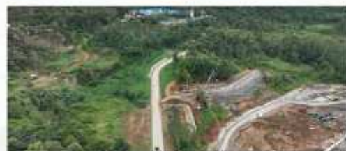
Progres Pembangunan Jalan Akses Kanan
