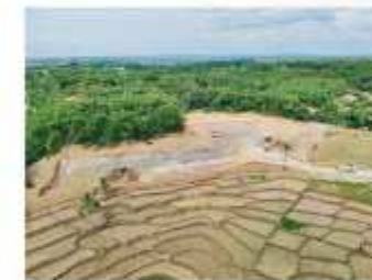
Area Maindam (STA 1+100 SD STA 1+250)
