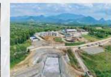
Dental Concrete Maindam STA 1+575 - STA 1+610
