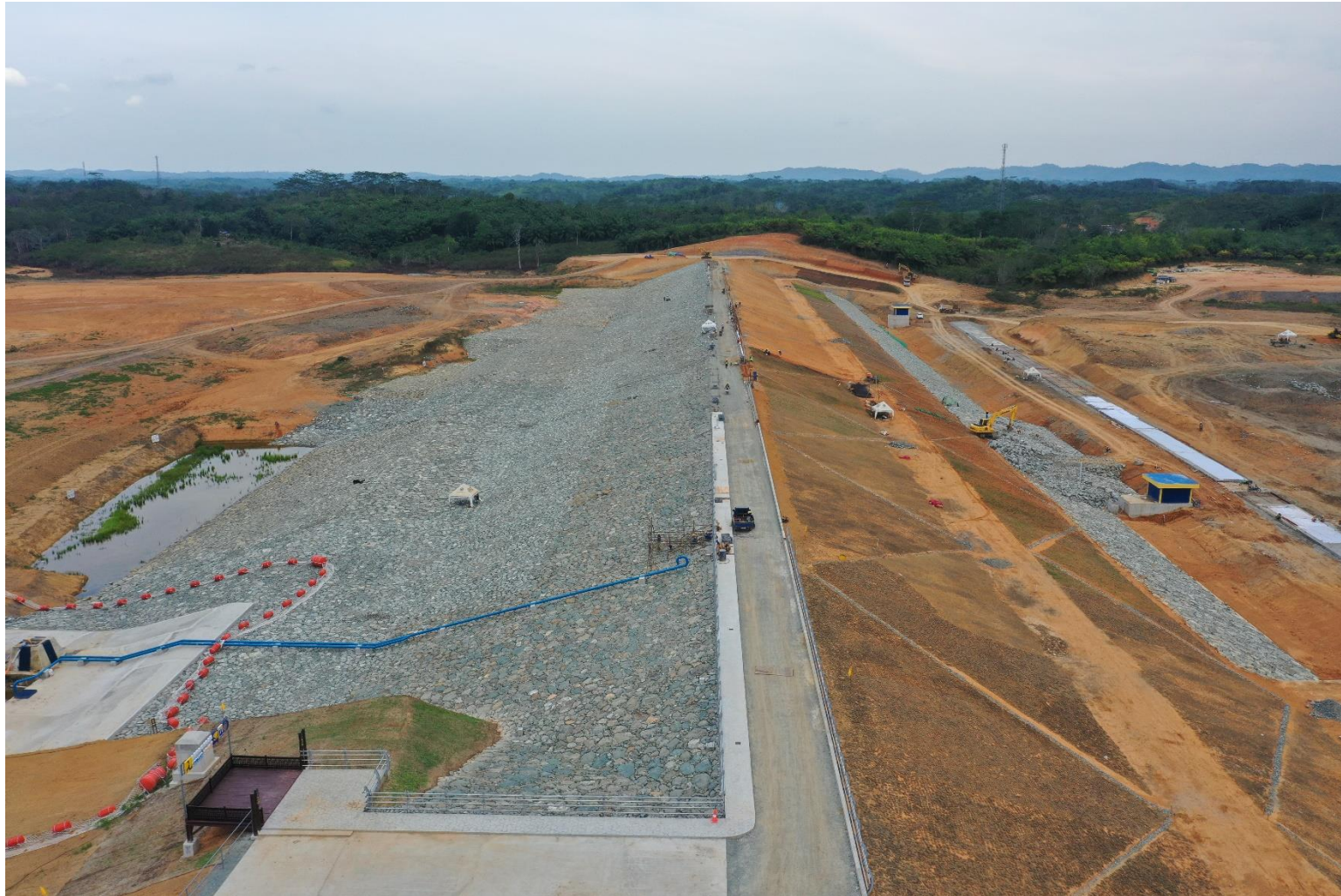
Gambar 22. Progress Pembangunan Bendungan Sepaku Semoi 17 Oktober 2023
