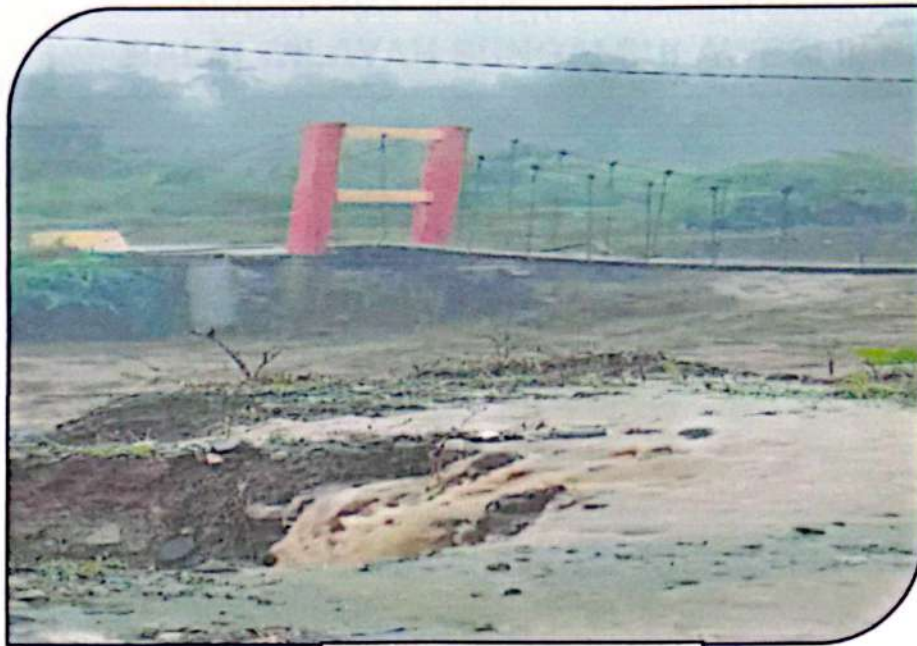
Kondisi Banjir Desa Labuan
