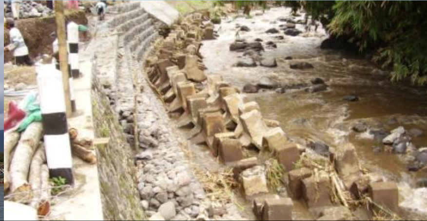
Perbaikan Revetment
